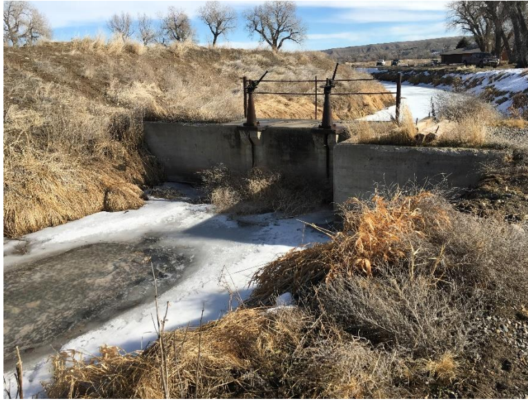
Level II: Lucerne Canal
