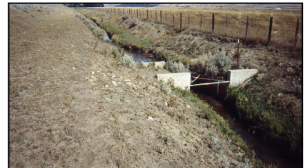
Des Moines flume
